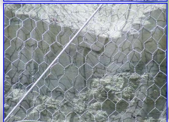
**Foto 2 – R.E.C.S.™ GS.** Baustelle in der Nähe von Savona zur Absicherung eines Hanges rückseitig einer Gewerbehalle. Die flyschöide Litologie führte zu einem ständigen Abgrusen von Feinmaterial und gelegentlichen Abstürzen von Arenitblöcken.
