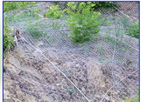
**Foto 1 – R.E.C.S.™ MET.** Verwendung auf einer Baustelle nahe Genova. Das Problem bestand im ständigen Absturz von Gesteinssplintern auf die darunterliegende Straße und den darunterliegenden Platz.
